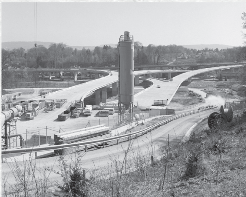
2009 Eröffnung Uetlibergtunnel A3 35
