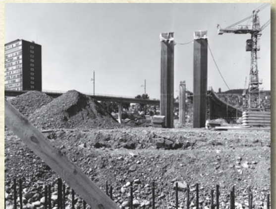
1968 Bau des Hardturmviadukts Zürich 25
