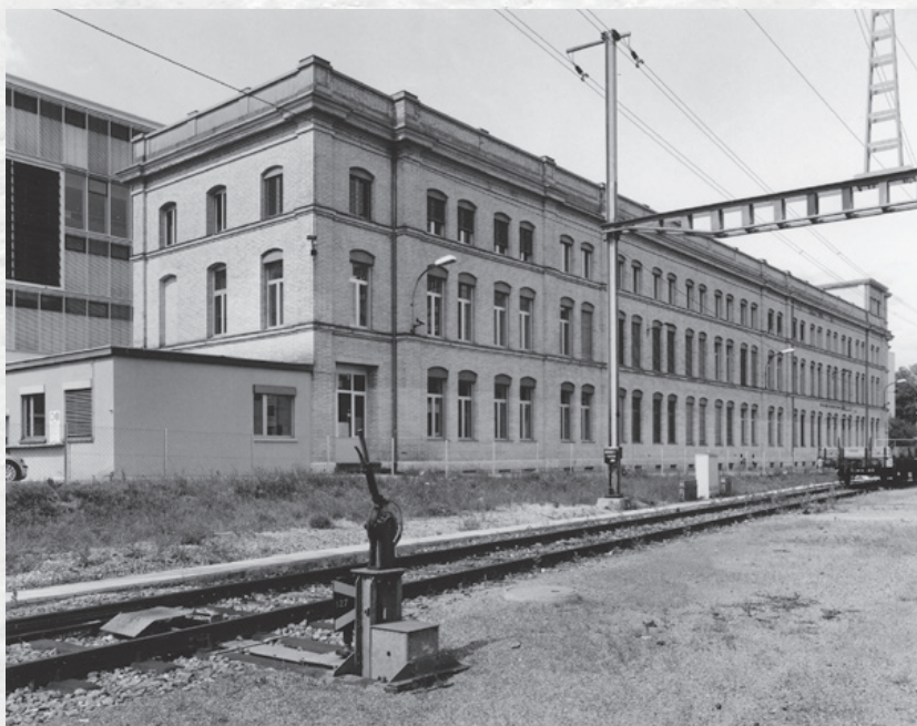
2012 wurde das MFO-Gebäude in Oerlikon um 60 Meter verschoben 36
